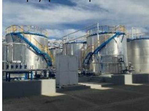
Резервуарный парк с базовым маслом
